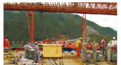
日前，上海通用电焊机NB-500KR半自动气体保护焊机成功应用于贵州高速公路都格北盘江大桥钢结构焊接工程项目。都格北盘江大桥，又称“杭瑞高速公路北盘江大桥”，大桥全长1341.4米，主跨720米，桥塔高269米，桥面距离水面564米。（王判明）
